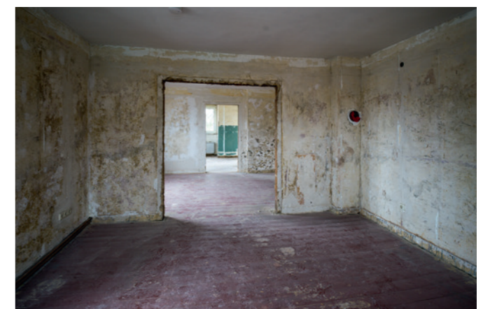
↑ Für die Erweiterung der obersten Wohnung der Hospitalstraße 9 wird der Bestandswohnraum mit dem Dachgeschoss verbunden und gleichzeitig aufwändig saniert; Foto: © ebv
