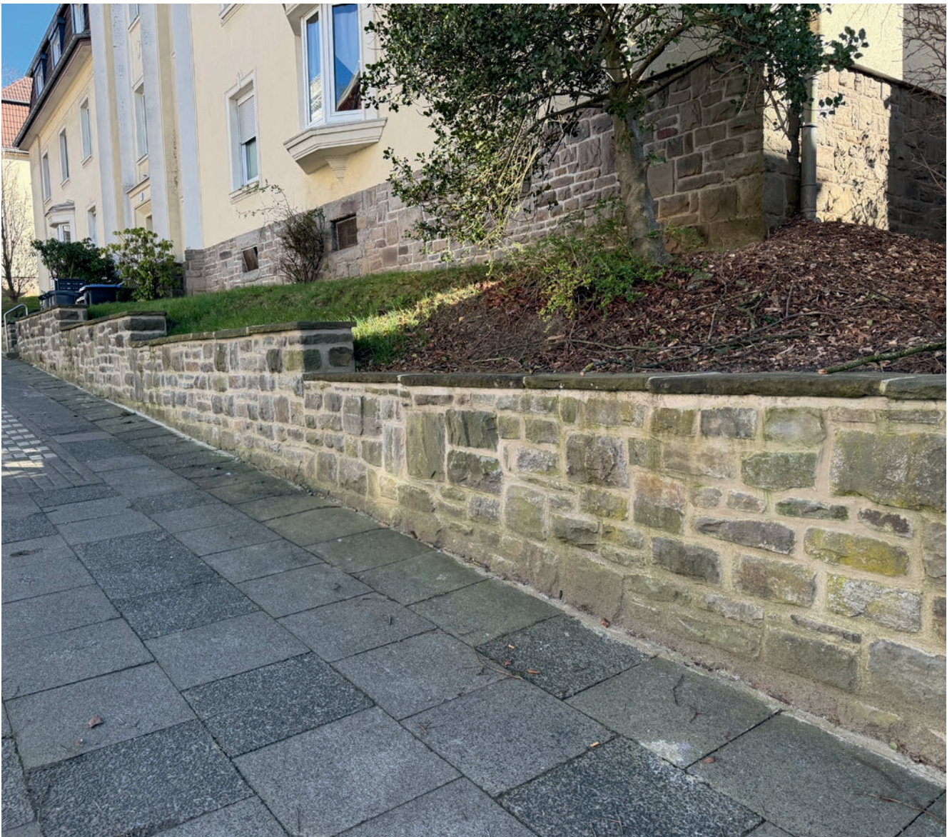
Für die unter Denkmalschutz stehenden Liegenschaften in der Hansastraße wurde die ebenfalls unter Denkmalschutz stehende Natursteinmauer saniert; Foto: © Anette Gericke
