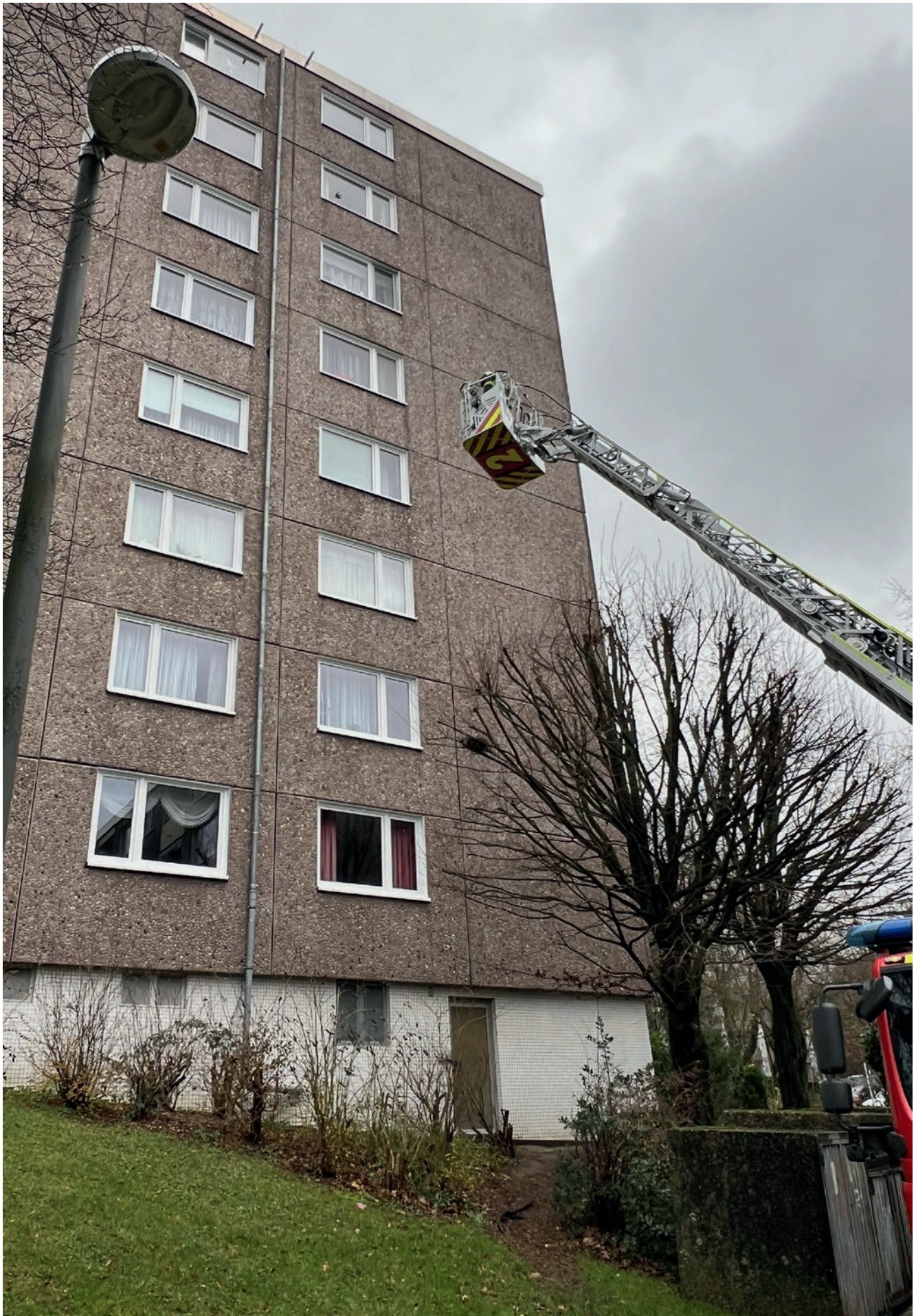
Für die Köttershöhe 10 wurde eine neue Feuerwehraufstellfläche geschaffen; Foto: © Anette Gericke
