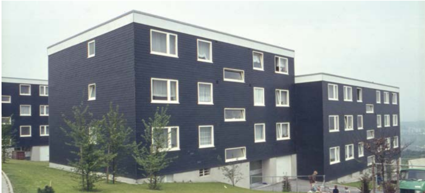
Die neu errichteten Bauvereinshäuser am Dasnöckel. Die Siedlung Mastweg, am Rande von Wuppertal-Cronenberg gelegen, wurde zu einem weiteren Beispiel für den Großsiedlungsbau zu Beginn der 1970er Jahre ohne Anbindung an die Stadt.
