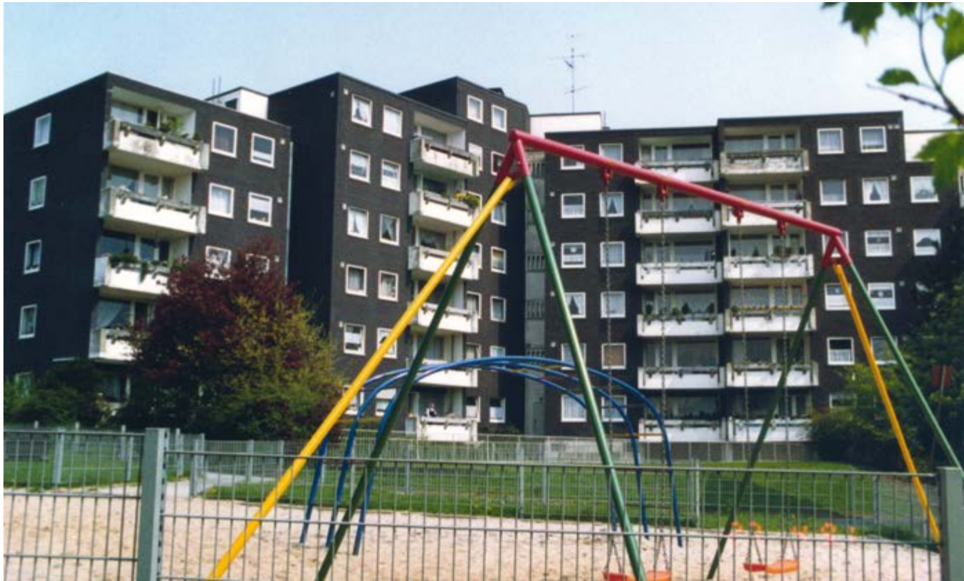
Die Häuser an der Gildenstraße. Wie bei vielen Eisenbahner-Wohnungen der Fall, haben auch die Bewohnerinnen und Bewohner der Gildenstraße einen zusätzlichen Freizeitvorteil. Sie liegen an der Fahrradtrasse, der ehemaligen Rheinischen Bahnlinie.
