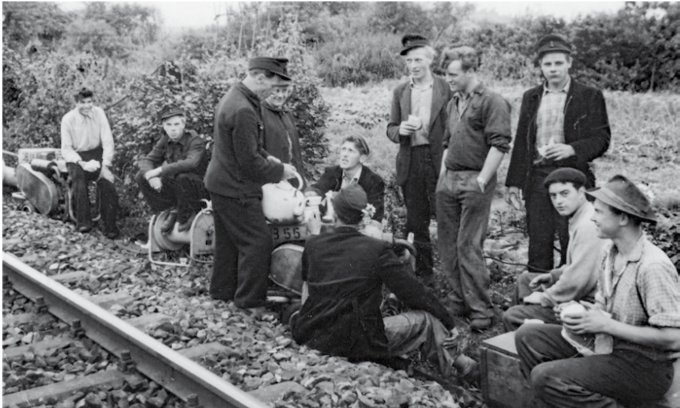
Frühstückspause. Gleisarbeiter mit Arbeitsgerät an der Bahnstrecke von Wuppertal nach Düsseldorf bei Gruiten in den 1950er Jahren. Über Wuppertal hinaus baute der Eisenbahn-Bauverein Wohnungen auch in Haan und Gruiten.
