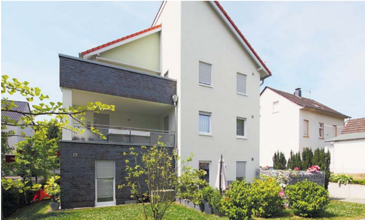
Der nahe gelegene Bahnhof war schon vor einhundert Jahren für den Eisenbahn-Bauverein ein guter Grund dafür in Gruiten Wohnungen zu bauen. Genau diese Qualität ist wieder gefragt. Linke Seite: EBV-Häuser an der Sedanstraße in Barmen mit Zugang zur Fahrrad-Trasse.
