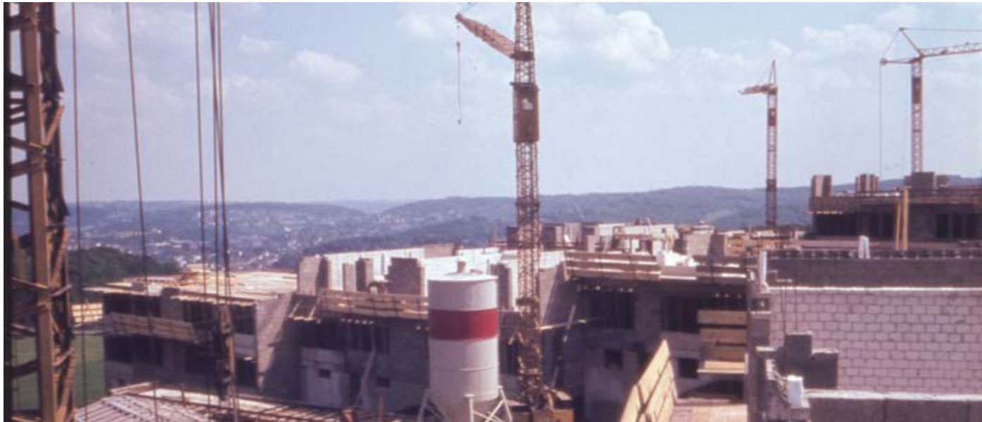
In den 1970er Jahren entstanden neue Stadtteile oftmals weit außerhalb der städtischen Bebauung. Der Eisenbahn-Bauverein beteiligte sich Anfang der 1970er Jahre am Bau der Siedlung Dasnöckel in Wuppertal-Vohwinkel.
