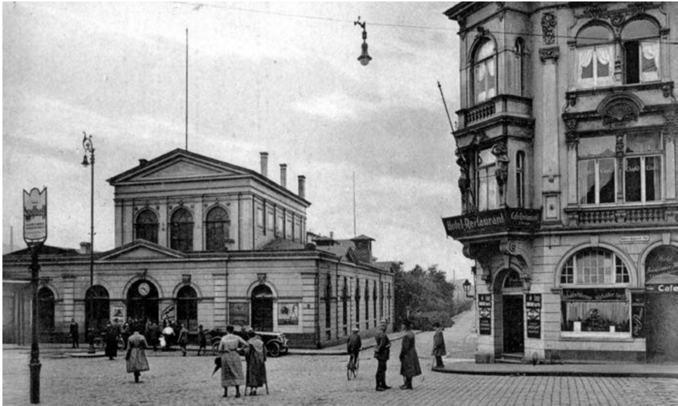
Eröffnet 1847, lag der Bahnhof Rittershausen an einem bedeutenden Bahn-Verkehrsknotenpunkt. 1930 wurde er in Wuppertal-Oberbarmen umbenannt; das Empfangsgebäude nach Kriegsschäden 1980 abgerissen. Linke Seite: Schwarzbach, Oberbarmen, 1929
