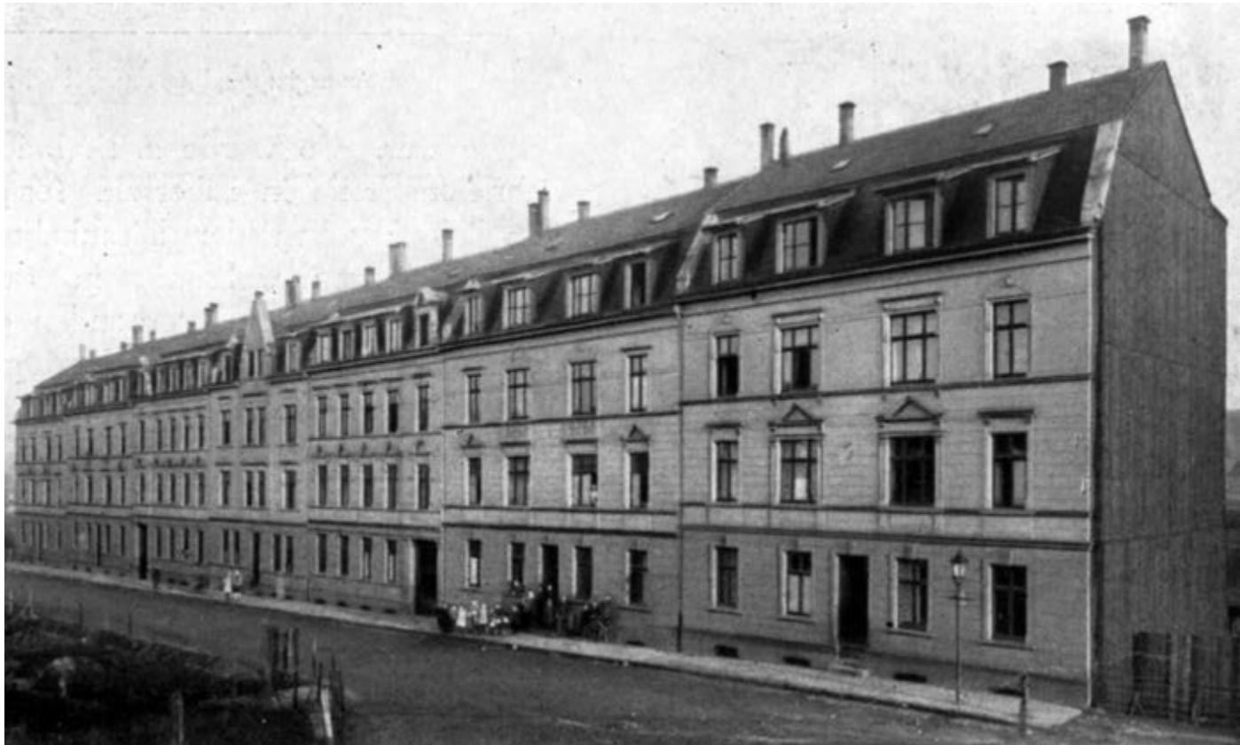
Häuserzeile des Eisenbahn-Bauvereins von 1902/03 an der Meininger Straße in Langerfeld. Die Häuser erhielten großzügige Gartenparzellen und Ställe für die Kleintierzucht.
