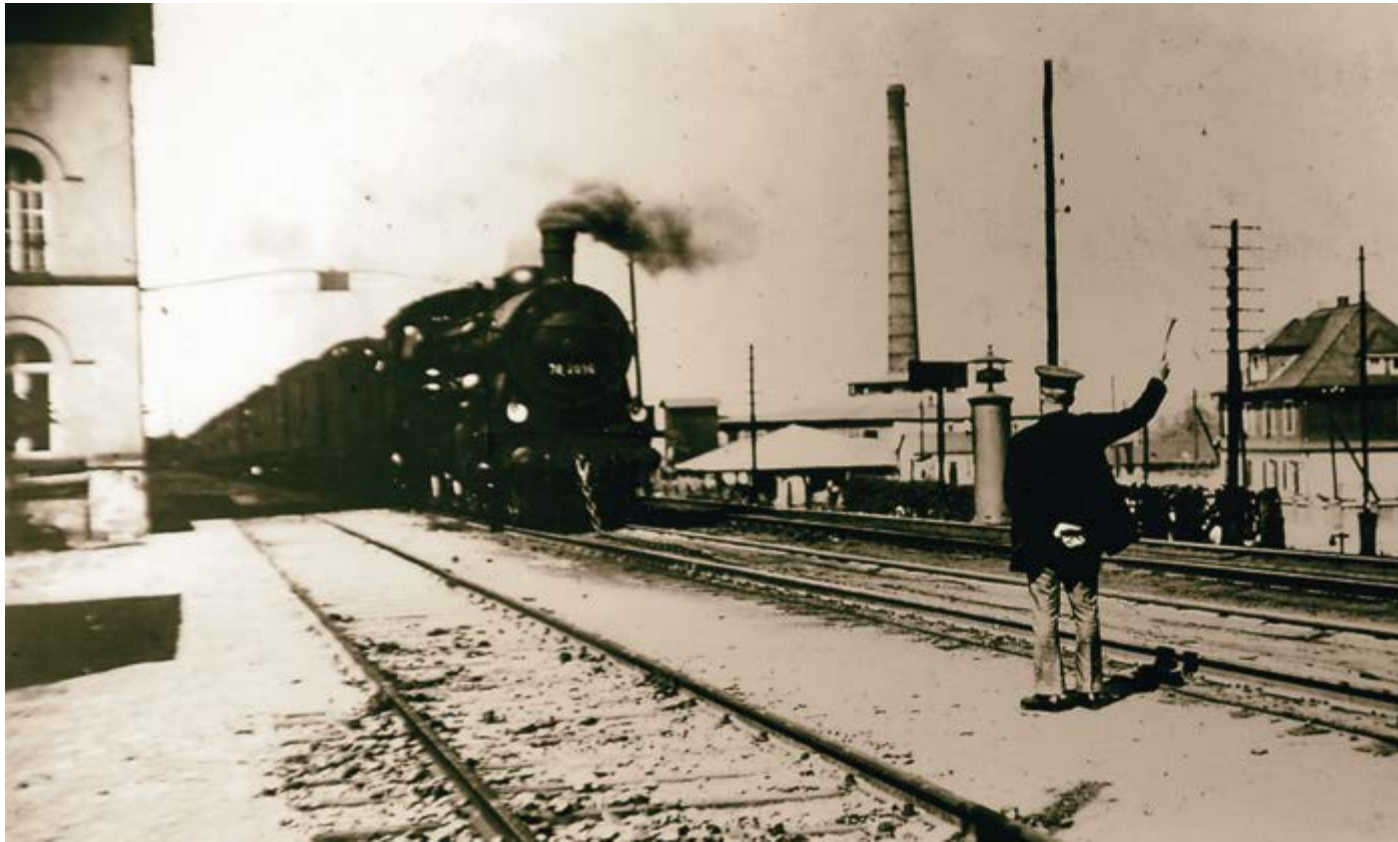
Bis in die 1920er Jahre wurden die Züge in Richtung Elberfeld auf der Steilstrecke vor Hochdahl vom jeweils nach unten fahrenden Zug mit Hilfe einer Stahlkette hochgezogen. Ein Bahnbeamter leitete den Vorgang.
