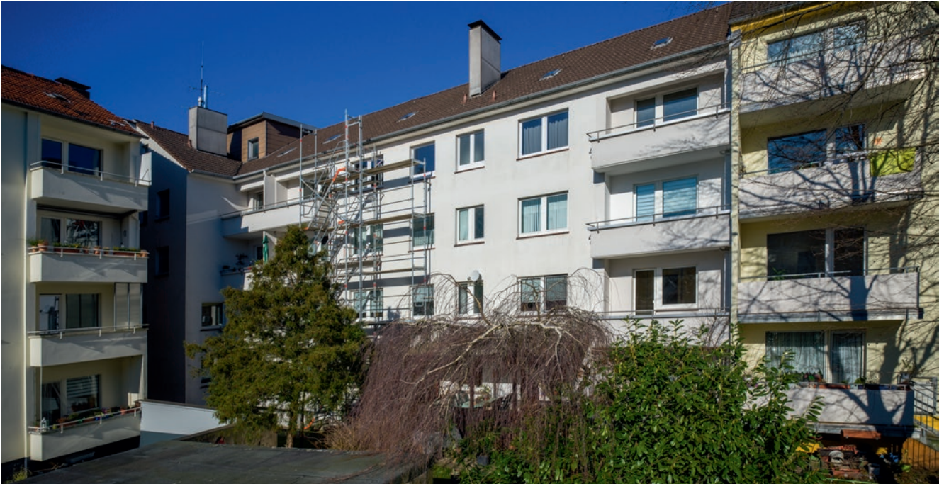
Neue Rettungswege in der Gerstenstraße bieten gleichzeitig die Chance auf einen Balkon. Foto: © ebv.
