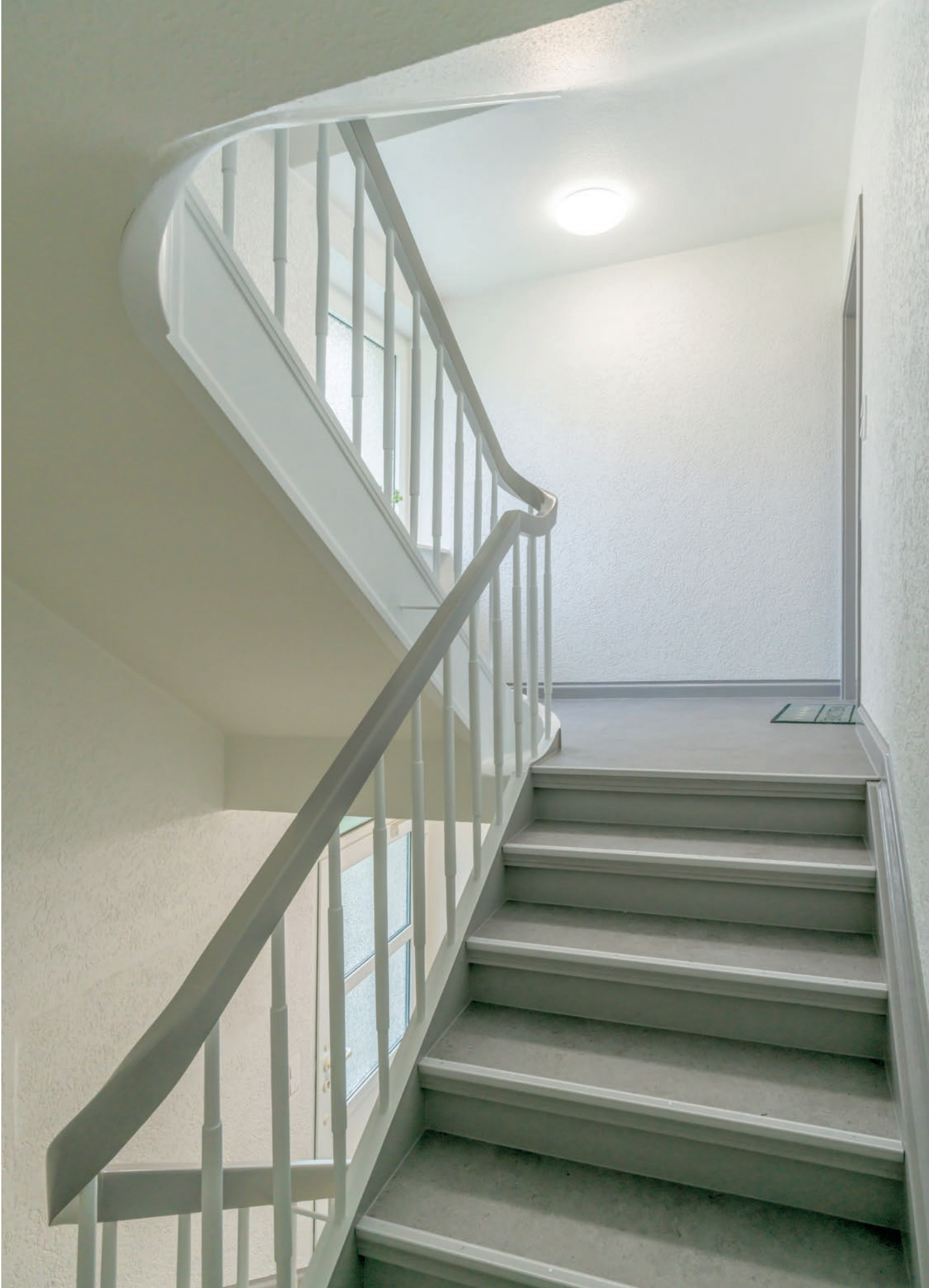
Sanierungsarbeiten im Treppenhaus machen den Charme des Altbaus sichtbar. Foto: © ebv.
